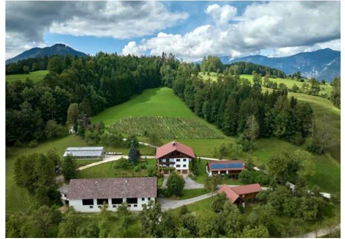
Bauernhof in Roßleithen
